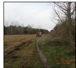
Oberflächenwiederherstellung der Kabelpflugtrasse Rod- leben (Am Wäldchen)
