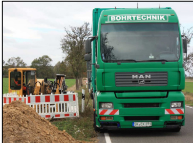
Tiefbauarbeiten mit einer HDD-Spülbohrmaschine auf der Hauptkabeltrasse Rietzmeck - Neecken
