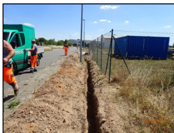
Offene Bauweise in Roßlau Gewerbe- gebiet Mittelbreite
