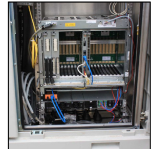
„Innenleben“ eines Multifunktionsgehäuses in Roßlau, Berliner Straße – Vectoring DSLAM 2510
