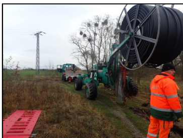
Verlegung mit Kabelpflug in Rodleben (Am Wäldchen)
